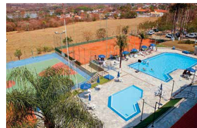
Ibirá: manutenção preventiva e novos equipamentos
