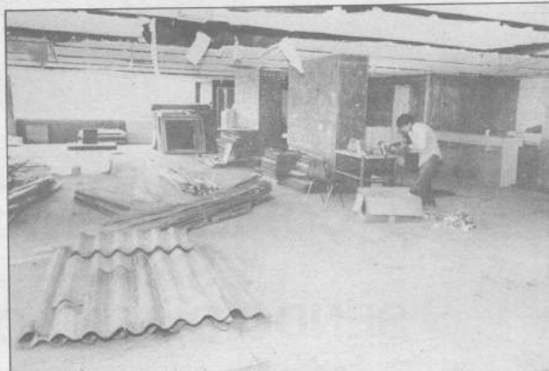
As obras da nova Sede Administrativa caminham a passos largos.
